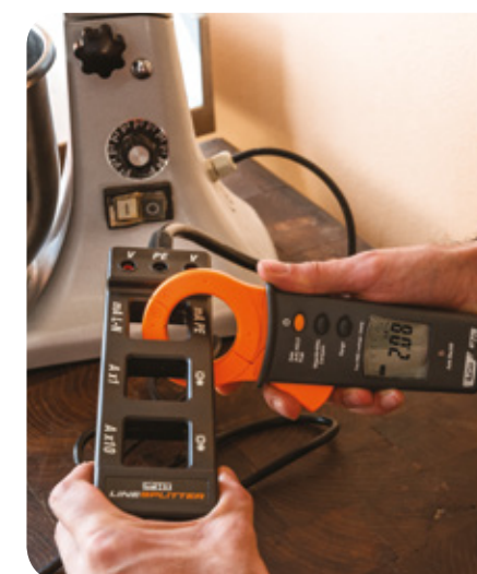
Misura della corrente di dispersione su conduttore di protezione (PE).
