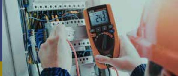
Nell'ambito degli impianti residenziali, la normativa CEI 64-8 impone di eseguire alcune verifiche, al fine di certificare che l'impianto sia stato realizzato a regola d'arte. Oltre ai classici strumenti per rilevazione di tensione e corrente, HT ITALIA dispone di strumenti semplici e portatili per le classiche misure di terra, differenziali ed isolamento.
