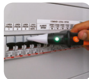
Individuazione interruttore a protezione della linea.
