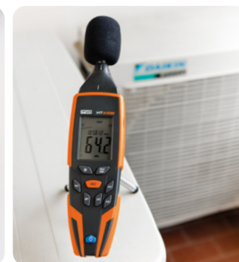
Misurazione del rumore di una pompa di calore con HTA102
