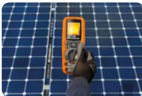
Campo FV: Analisi Termografica.
